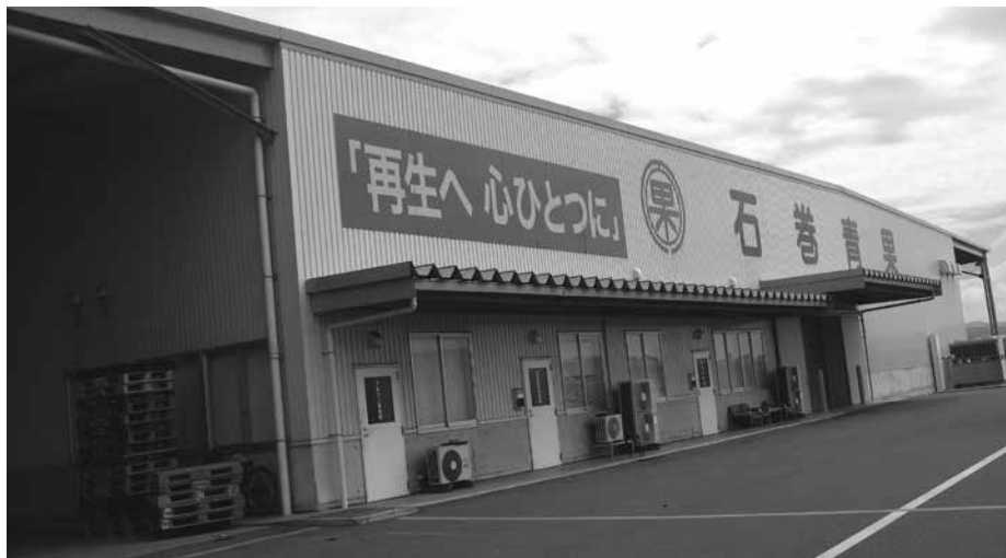
東日本大震災をきっかけに立地を見直し施設も整備した石巻青果
